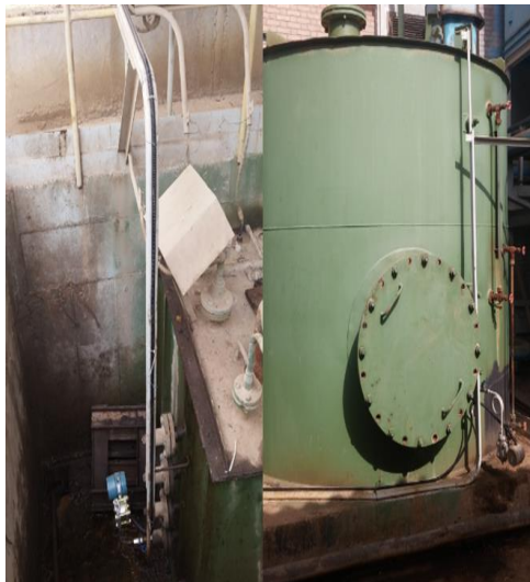
شکل ۱۱- نصب و راه اندازی ترانسمیترهای فشار هیدرواستاتیکی
