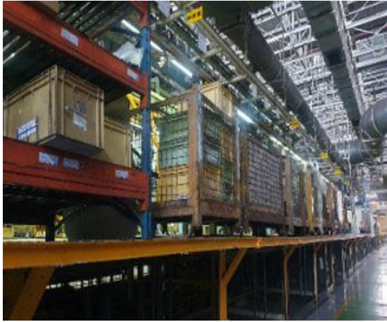
شکل ۲۸- وضعیت خط سکو قبل از اجرای پروژه
