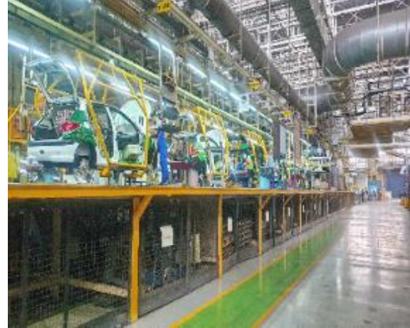
شکل ۲۹- وضعیت خط سکو بعد از اجرای پروژه
