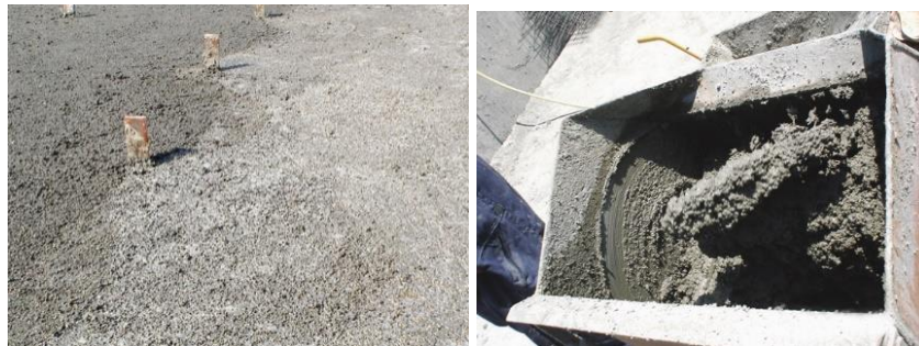
شکل ۵- مثالی از مخلوط شدن مواد خشک و سیمان با آب برای تولید بتن سبک، عایق و الیاف دار (الیافی) مورد نظر با یک دستگاه ملا ساز ساده و ریختن مخلوط آماده گشته بر روی سطح
