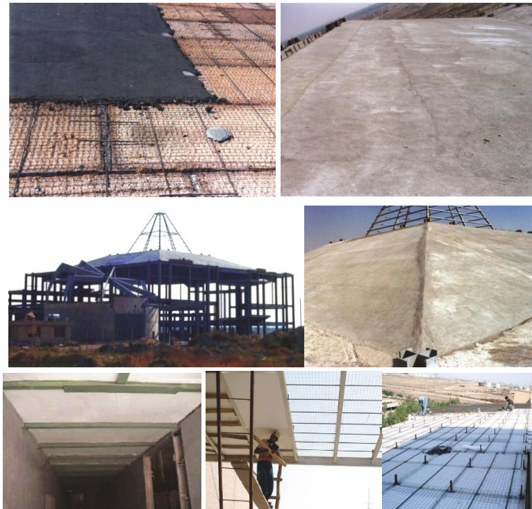
شکل ۶- نمونه هایی از بهره گیری ساده از سامانه سبک مسلح و عایق مورد نظر و اجزای آن در ساخت سقفهای مسطح و شیب-دار در چارچوبهای رایج و معمول بیان گشته در تصویر شماره ۷ مثالی شماتیک از چگونگی قرارگیری مشبکهای فلزی پیش جوش شده، نوارهای فلزی اتصال، میلگردهای حمایتی و ... برای اجرای یک سقف ساخته شده از بتن سبک مسلح و مرکب ارتجاعی در چارچوبی مشابه با سقفهای معمول موسوم به مرکب (کامپوزیت) نشان داده شده است [۱،۳،۴].
