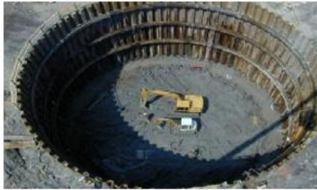
شکل ۲- اجرای سپرفلزی در خاک دانه ای
