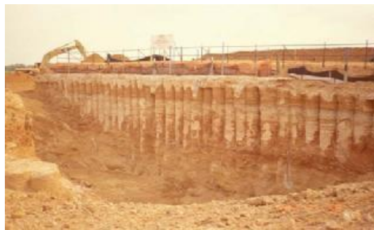
شکل ۳- شمع های درجا به صورت پیوسته (آب بند)
