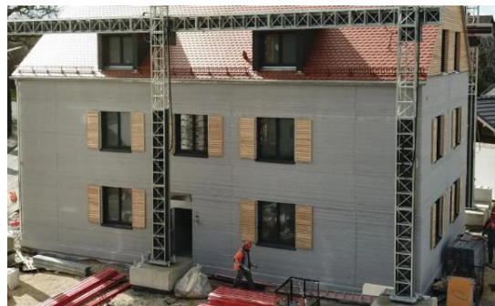
شکل ۲- اولین آپارتمان چند طبقه ساخته شده با پرینت سه بعدی بتن در کشور آلمان
