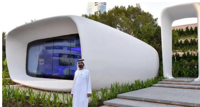
شکل ۳- ساخت ساختمان اداری در دویی با استفاده از تکنولوژی پرینت سه بعدی بتن که منجر به کاهش ۵۰ درصدی نیازه نیروی انسانی و کاهش ۶۰ درصدی دورریز و ضایعات، در مثنایسه با ساختمان های سنتی، گردید [GolfNews]
