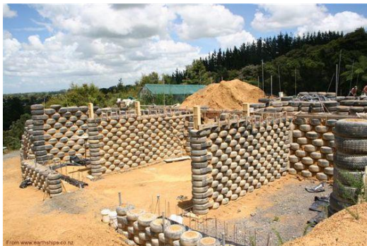
شکل ۸- ساخت دیوارها با استفاده از لاستیک‌ها [۳۰]
